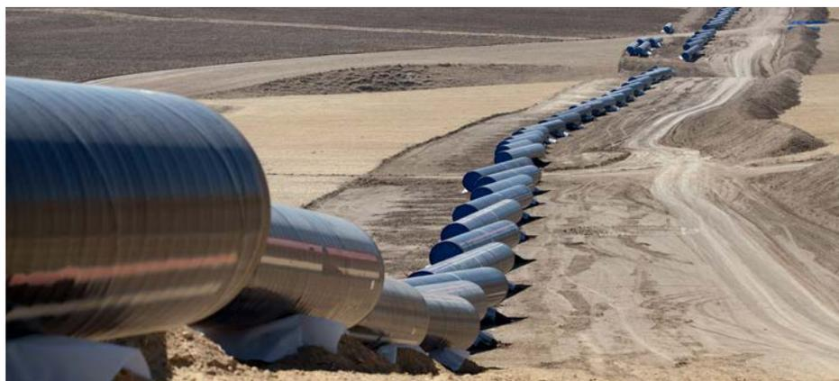
位于土耳其的跨安纳托利亚天然气管道, 该段管道为“南部天然气走廊”项目管道系统的核心部分。
